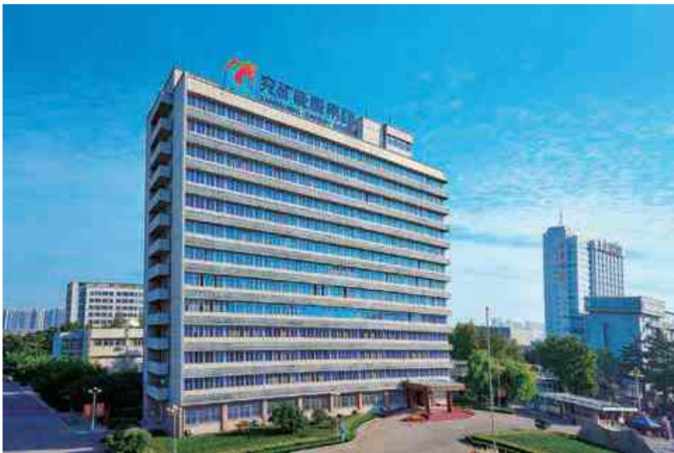
兖矿能源大楼
